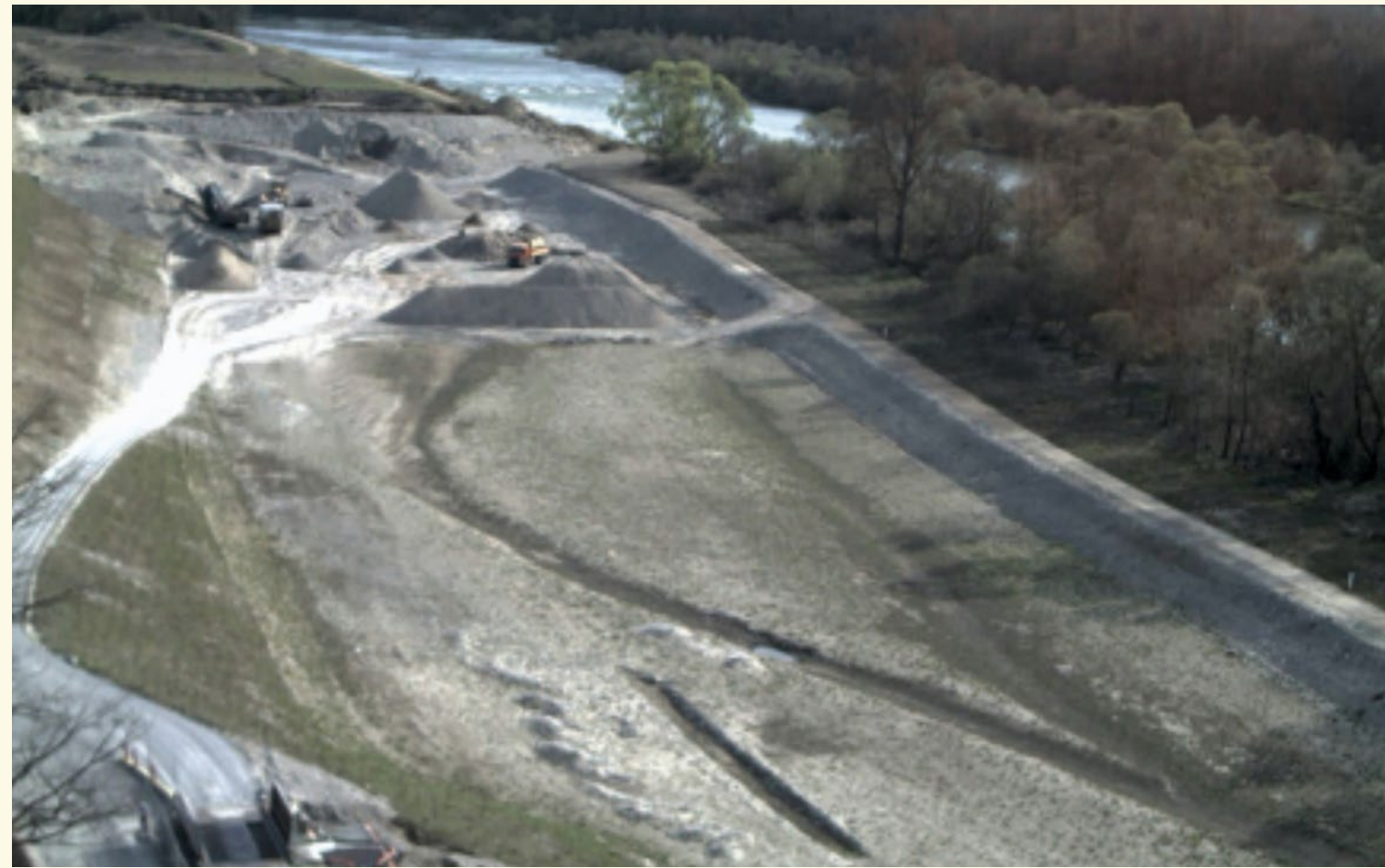
Bilder 1–3: Hochwasserrückhalteraum Weil-Breisach, Teilabschnitt I:
