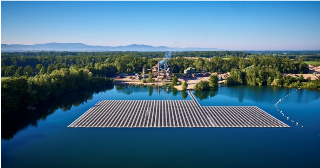
Abbildung 1: Schwimmende PV-Anlage in Renchen
