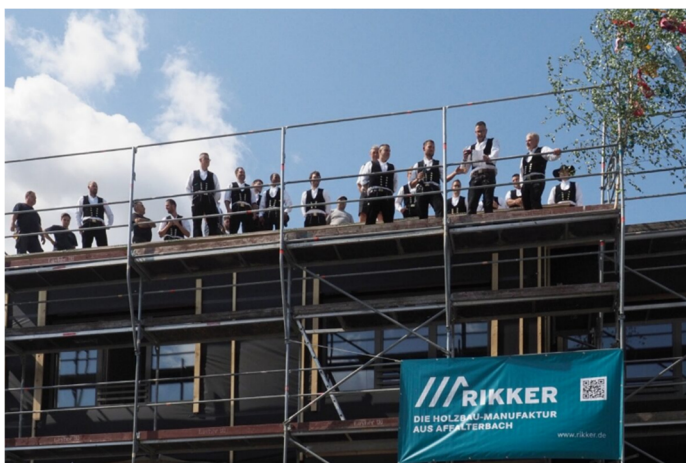
Öffentliches Richtfest unserer Aufstockung des Firmengebäudes Im Sommer 2025
