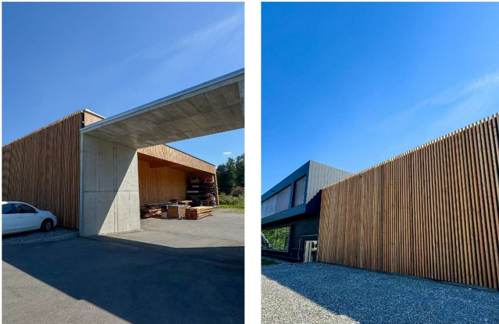
42 m 3 Douglasien-Fassade am Erweiterungsbau
