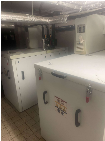
Blockheizkraftwerk (BHKW)
