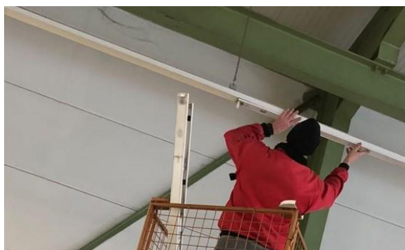
Bild 2 Einbau der neuen LED Leuchtmittel
