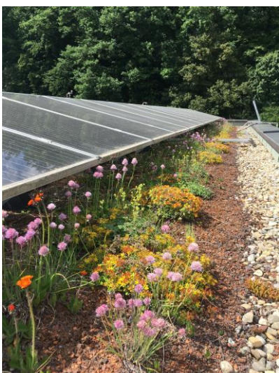
PV-Anlage mit Begrünung
