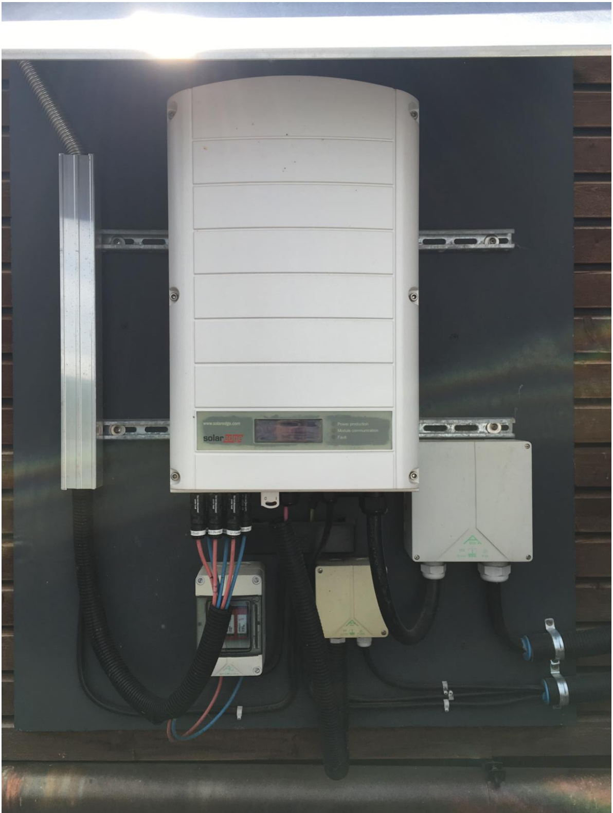
Wechselrichter
