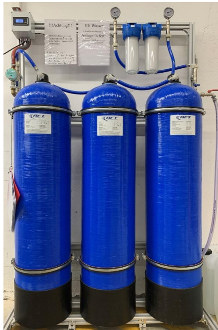
VE-Wasseraufbereitungsanlage
