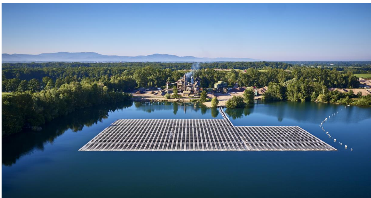
Abbildung 1: Schwimmende PV-Anlage in Renchen
