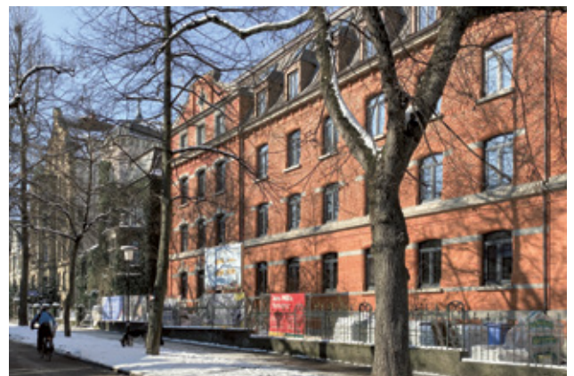
In bester Lage in der Ulmer Heimstraße haben wir neun Wohneinheiten kernsaniert.
