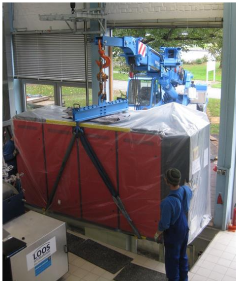
Abbildung 2: Einbau eines Blockheizkraftwerks
