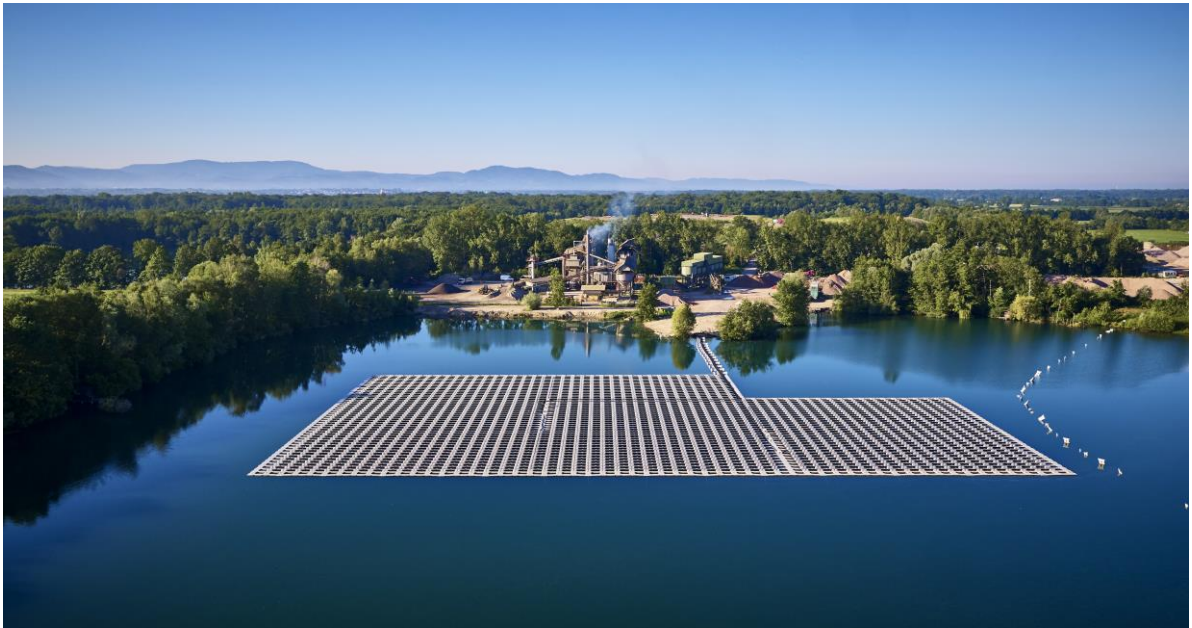
Abbildung 1: Schwimmende PV-Anlage in Renchen
