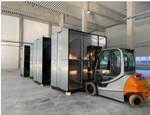
Anlieferung der nachhaltigen Wärmetauscher zur Reduzierung des Energiebedarfs im neuen Oberflächenzentrum
